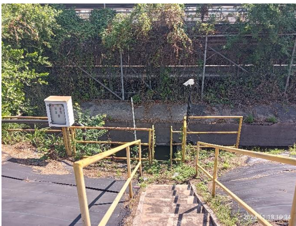
รูปที่ 3-22 ประตูกันน้ำบริเวณด้านหลังโรงงาน และฝ่ายชะลอน้ำและระบบกรองเพื่อลดปริมาณของแข็งแขวนลอย
