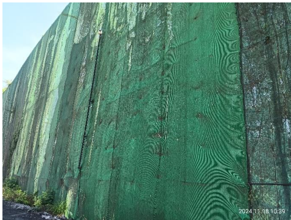
รูปที่ 3-12 กำแพงตาข่ายกันฝุ่นด้านที่ติดกับโรงงานอื่น
