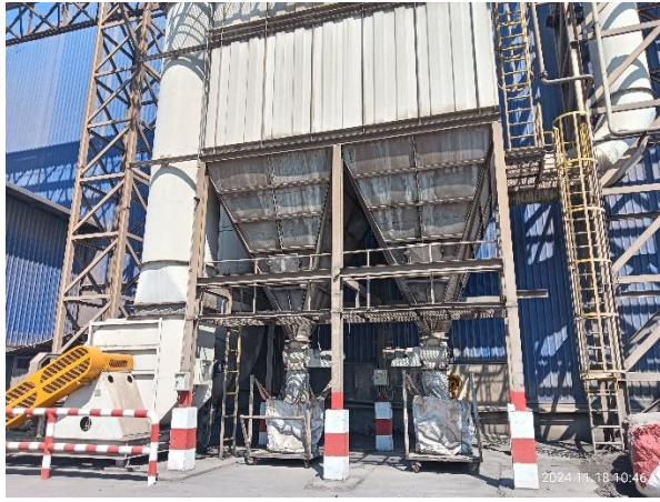
รูปที่ 3-11 ระบบ Dust Collector ของอาคารเท Slag และถุงเก็บรวบรวมฝุ่นรอส่งไปกำจัด
