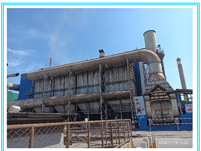
รูปที่ 3-10 ระบบ Dust Collector ของอาคารเท Slag
